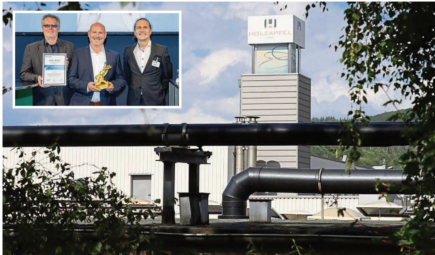
Über dem Gebäudekomplex der Holzapfel Group in Sinn thront das Logo der Firmengruppe. Über den Preis freuen sich (v.l.) Michael Kolb, verantwortlich für das Innovationsmanagement der Holzapfel Group, Maik Hormel, technischer Werksleiter der Holzapfel Metallveredelung und Dekotec GmbH, und Martin Metzner vom Fraunhofer Institut. Foto: Erik Wohler/Deutsche Messe AG/Ole Spata
