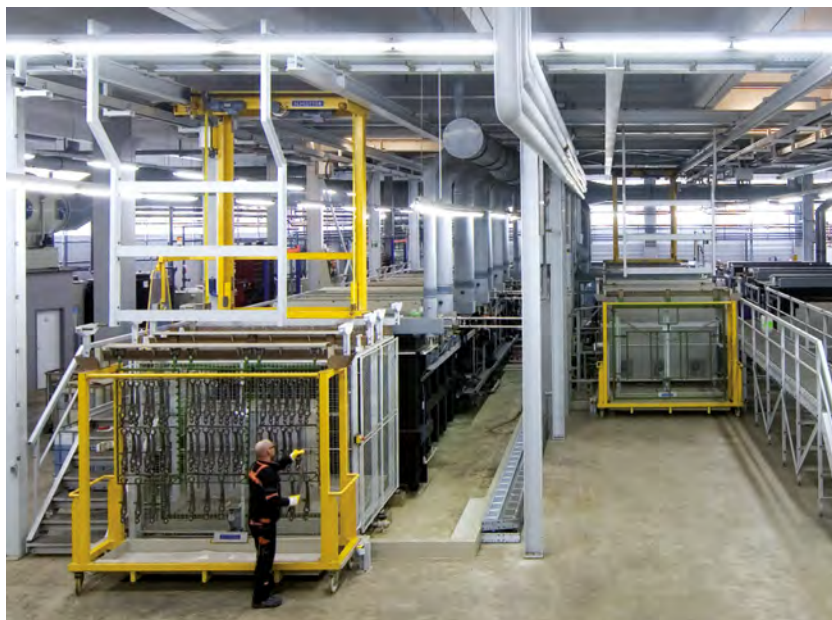
Abb. 12: Anlage zur Beschichtung von Bauteilen für die Wasserelektrolyse.
